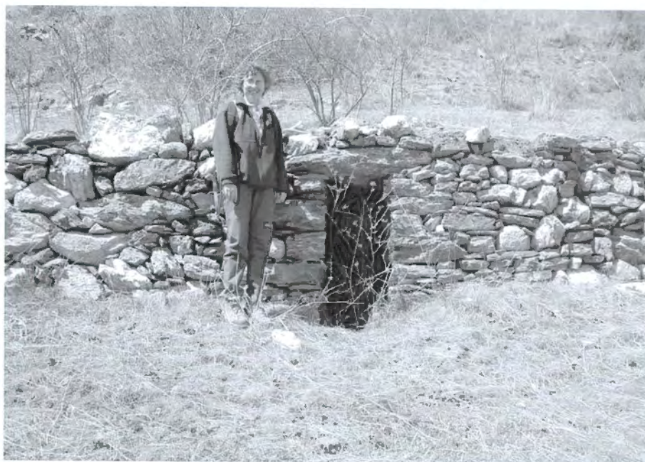
FIGURA 24. Entrada d'una «cabana de tros», prop d'Arrose. El mur del bancal, obrat amb pedra seca, evita l'erosió i rebaixa el pendent de les feixes. La cabana, perfectament integrada a l'obra, proporcionava aixopluc als qui treballaven en aquests trossos.
