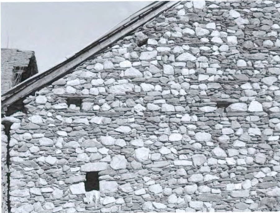
FIGURA 25. La proporció de cairells de gresos i pissarres del Cambroordovicià (roques fosques) i de granitoides (roques clares) és similar a la major part dels edificis de Son. Les lloses gruixudes de gresos i pissarres s'aprofiten per fer fileres regulars. Els cairells de granitoides són relativament irregulars. Per a les petites llindes s'utilitzen indistintament lloses o carreus de granitoides. En segon terme, es veu el llosat d'una casa, colonitzat per líquens.
