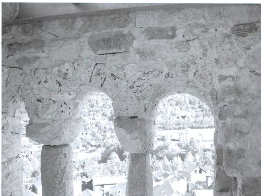
FIGURA 27. El campanar de l'església dels Sants Just i Pastor a Son és obrat majoritàriament amb carreus ben tallats de granitoides; les columnes de les finestres són d'una sola peça cilíndrica de granitoides tallats, mentre que els capitells són de travertí, com altres elements ornamentals del campanar.
